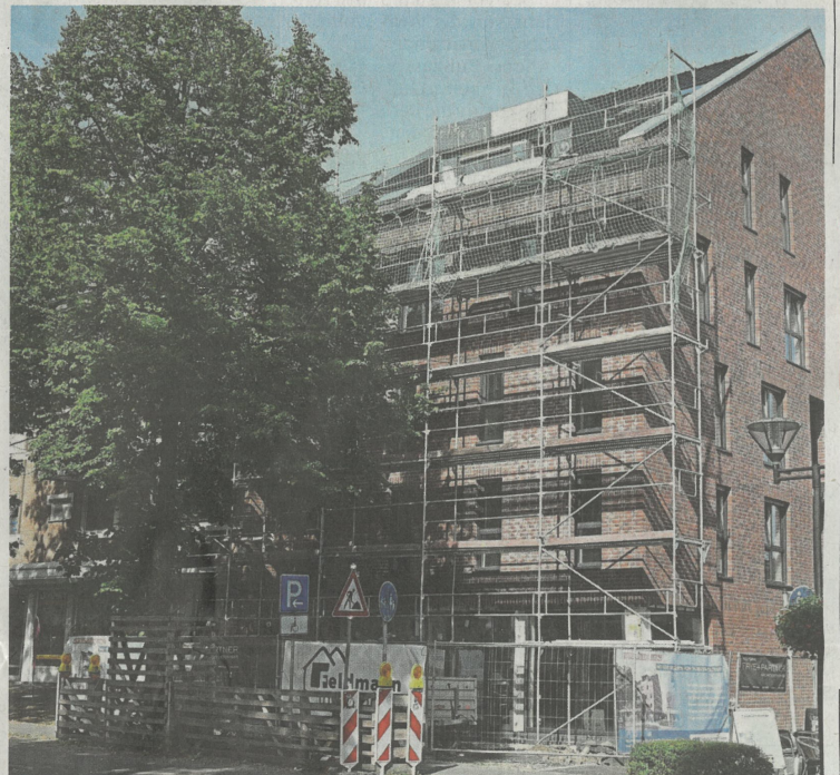
Kurz vor der Fertigstellung: In diesem Neubau wird Fielmann mit einer Filiale einziehen. Auch sonst tut sich etwas an der Marktallee. Foto: Michael Grottendieck
